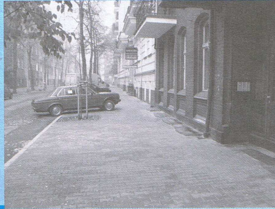
Wyremontowany chodnik przy ul. Limanowskiego
