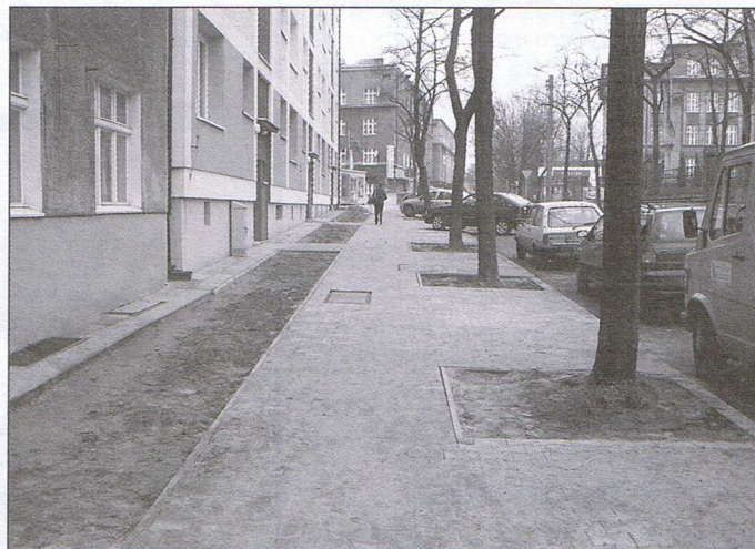
Wyremontowany chodnik przy ul. Stablewskiego
